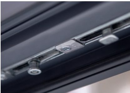
Unteres Auflaufelement in den Dreh-Kipp-Flügeln (RU)
