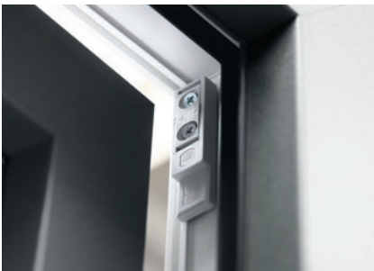
Verdrahteter Reed-Schalter auf der Oberseite
